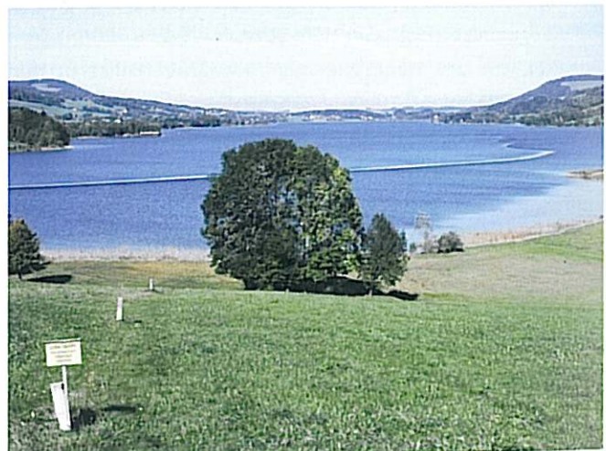
Der Irrsee während der Verlegung des Abwasserkanals (Foto: Albert Jagsch)
